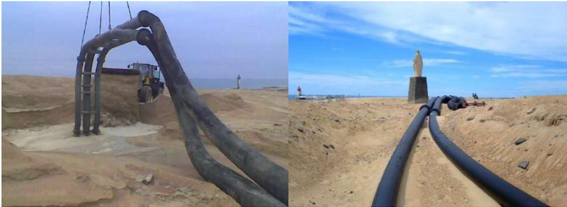
Illustration 104 : By-passing hydraulique à Capbreton ; pompage du mélange eau et sable à l'aide de l'hydro-éjecteur qui est relié par des tuyaux flexibles à la station de pompage (Source : Exca)
