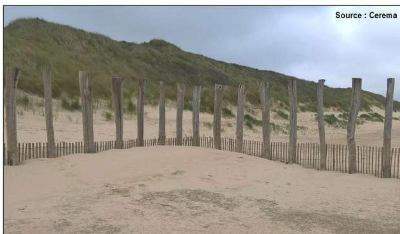
Illustration 79 : Accumulation significative au sein d'un casier à vent en haut de plage
