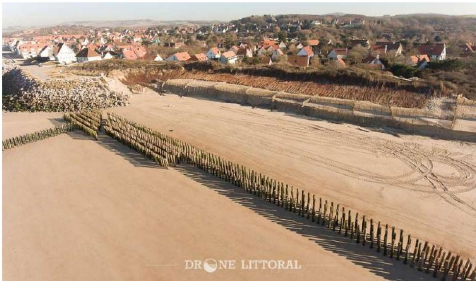
Illustration 121 : Dune d'Aval en 2017 ; implantation de 700 pieux hydrauliques (Source : Drone Littoral)
