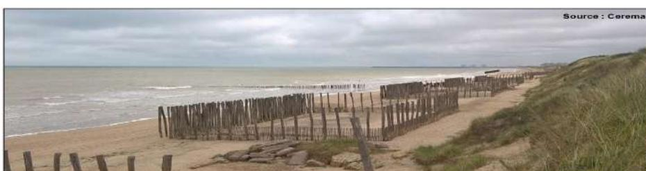
Illustration 77 : Série de casiers à vent en pieux hydrauliques et ganivelles sur le haut de plage
