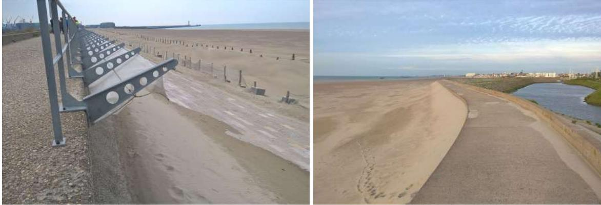
Illustration 25 : Pertes de sédiments sous l'effet de la déflation éolienne le long de la digue des Alliés, dispositif expérimental (Dunkerque Port) pour limiter les envols de sable (Source : Cerema)
