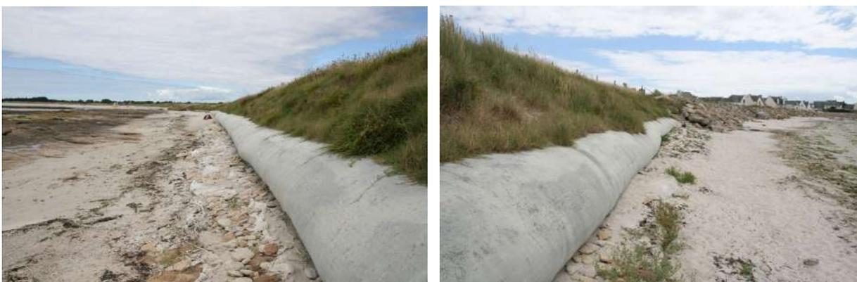
Illustration 139 : Ouvrage STABIPLAGE© parallèle au trait de côte et visible, affouillement en pied par endroit, avec les trois ouvrages perpendiculaires en arrière-plan (à droite), juin 2018 (Source : Cerema)
