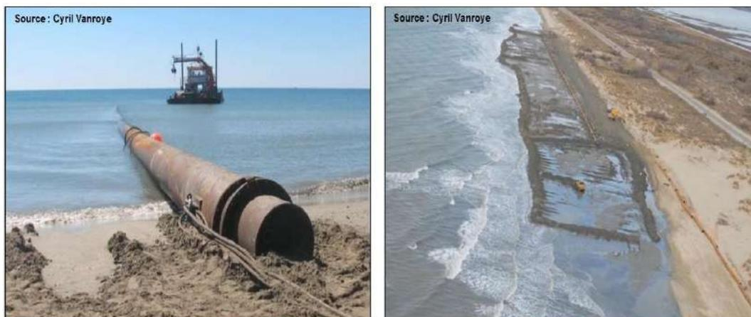
Illustration 32 : Conduit de refoulement des sédiments utilisé lors de l'opération de rechargement
