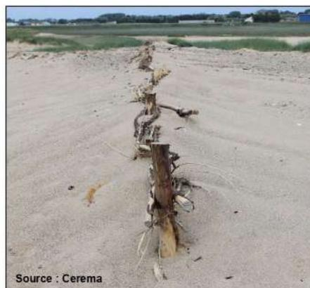
Illustration 58 : Fascines dénudées sur le haut estran et recouvertes de sable sur le cordon
