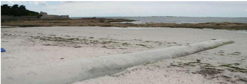
Illustration 140 : Un des ouvrages STABIPLAGE© perpendiculaire, installé en 2005 et visible en 2018 (Source : Cerema)
