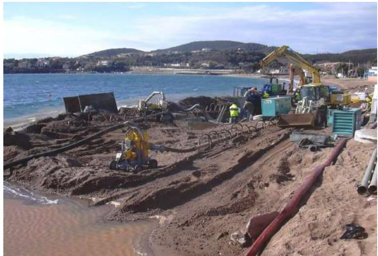
Illustration 96 : Mise en œuvre du système de drainage de plage ECOPLAGE sur la plage d'Agay en 2004 (Source : Cerema)
