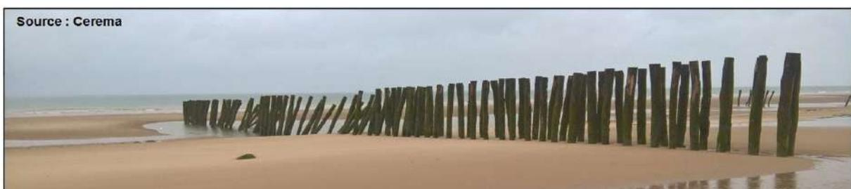
Illustration 74 : Rangée de pieux hydrauliques sur l'estran en avant de la dune d'Aval
