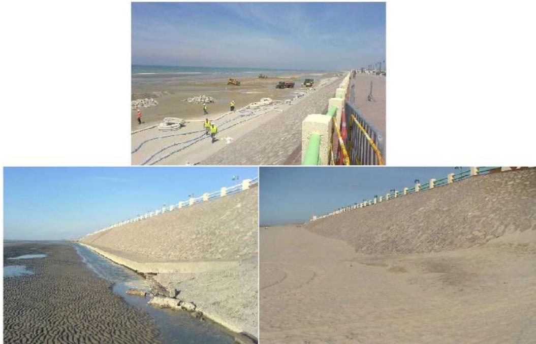
Illustration 90 : Travaux réalisés en 2008 et situation de la plage de Quend avant et après la mise en place du système de drainage de plage (Source : ECOPLAGE)
