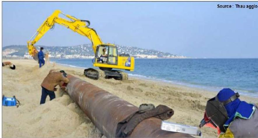
Illustration 34 : Mise en place de la canalisation de refoulement sur la plage du lido de Sète à Marseillan
