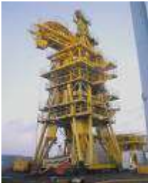
Pose de conduites rigides et flexibles
